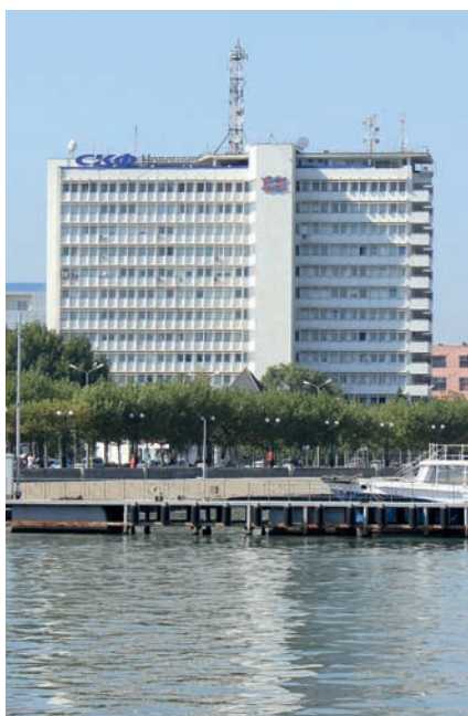
Офис ОАО «Новошип», Новороссийск
